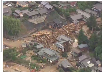
土石流等による被害 (新潟県村上市)
