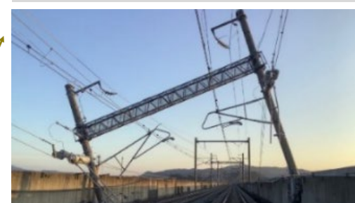
東北新幹線の電柱傾斜
